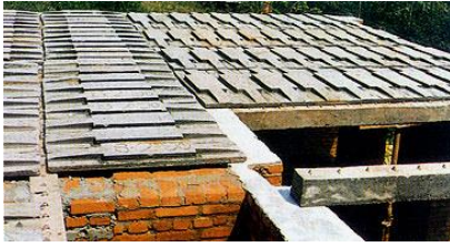
Fig. 2 Precast R.C. Planks
